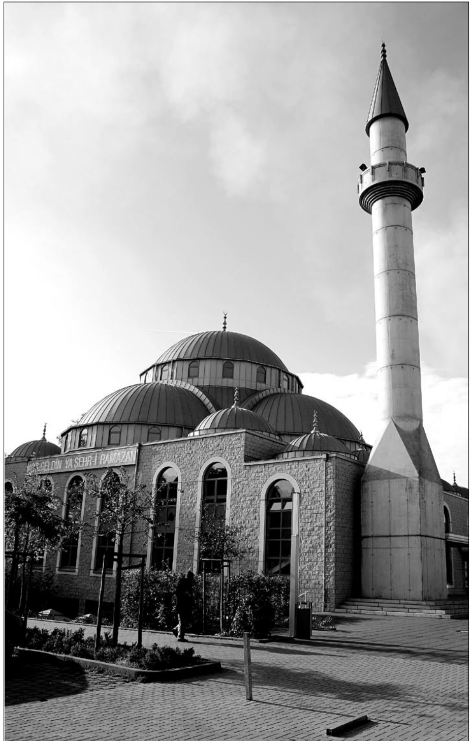
Außenansicht der DITIB-Moschee in Duisburg-Marxloh.
